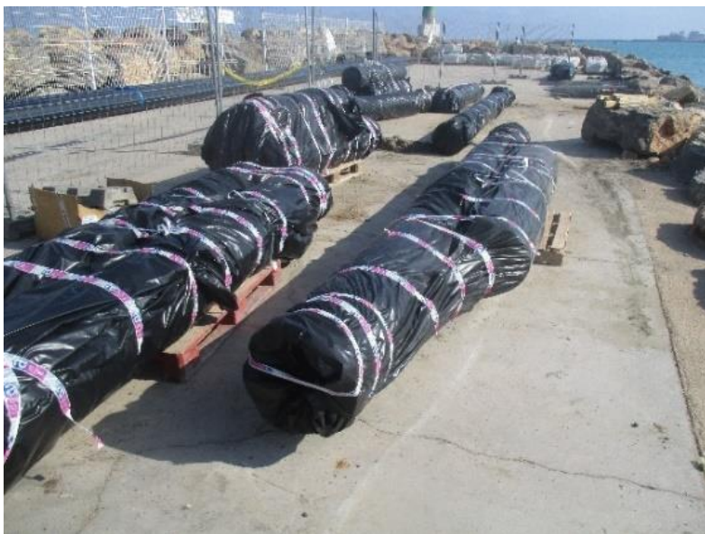
Imagen 4. Tubería sellada y señalizada para su traslado en condiciones de seguridad.
