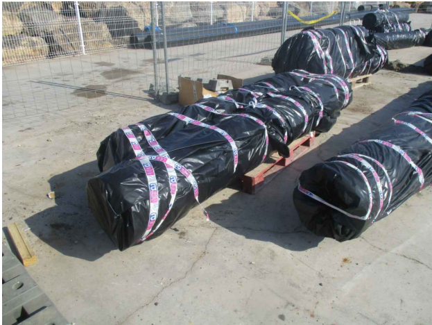
Imagen 2. Conducción de fibrocemento paletizada, sellada y señalizada para su posterior transporte.
